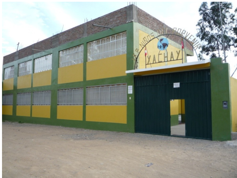
Fachada del proyecto y de la escuela Yachay en Ocopilla – Huancayo
